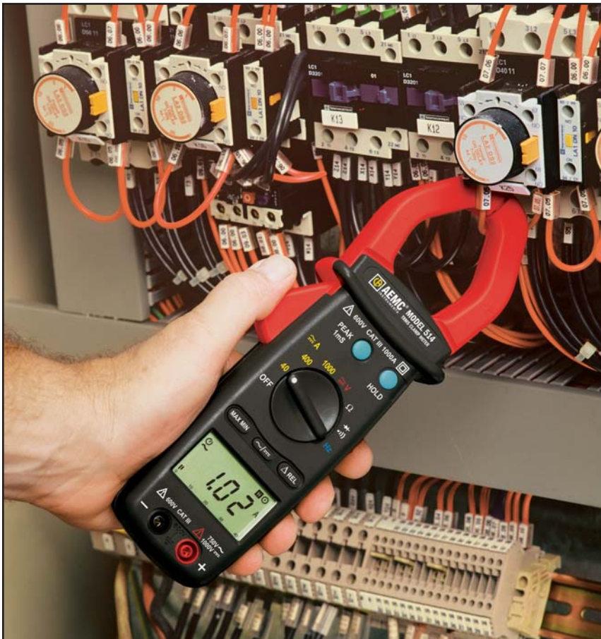
Medición de corriente en el sistema de control de una máquina con la pinza Modelo 514.
