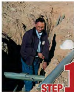
STEP 1 Remove damaged conduit
