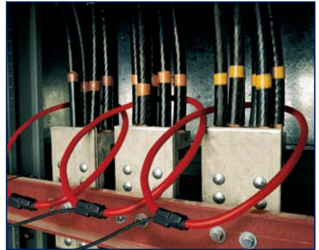
Flexibles para hacer mediciones fácilmente donde los instrumentos de pinzas estándar no tienen acceso.
