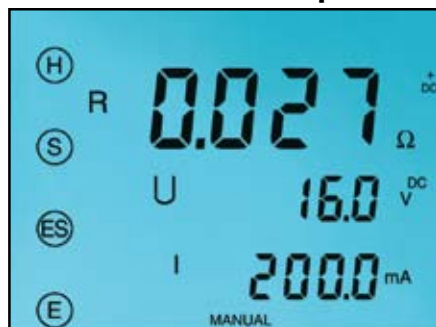
La prueba de conexión de 4 puntos muestra las conexiones de conductores, los resultados de la prueba de resistencia de conexión, tensión de prueba y corriente.
